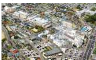
総合南東北病院（福島県郡山市）
