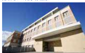
南東北がん陽子線治療センター（福島県山形市）
